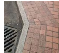
沿路石翻新，採用標準預製混凝土S1類型
