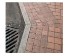
沿路石翻新，採用標準預製混凝土S1類型
