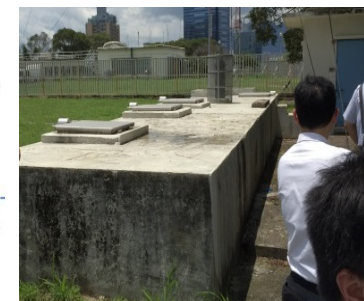
現有的水務署設施設施固定
