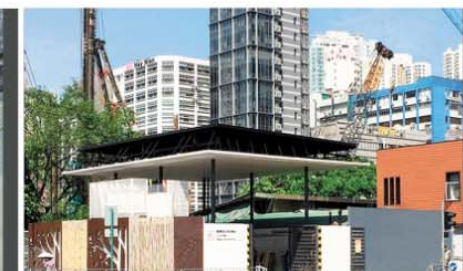
3 勵業街垃圾收集站
