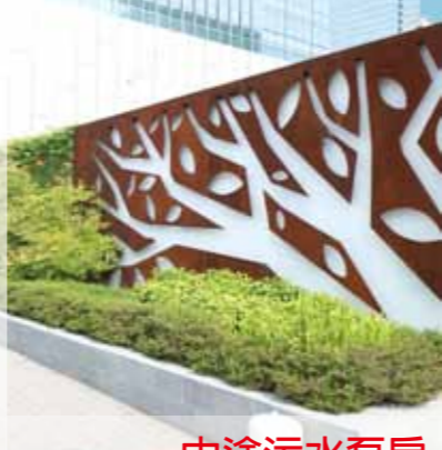
中途污水泵房
