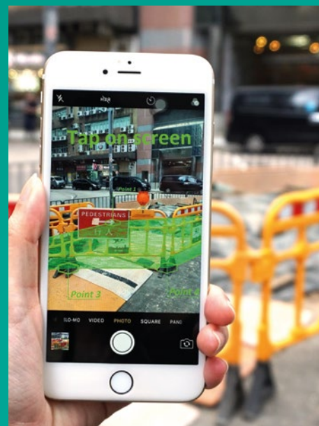
▼ 使用擴增實境定位功能為道路工程定位 Using AR to locate work site
