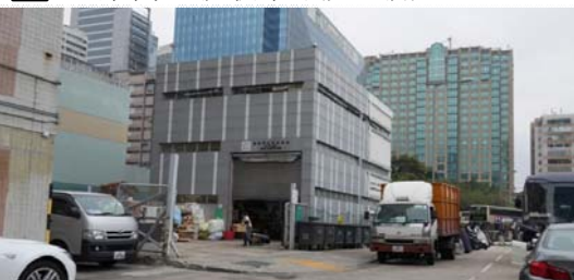
4 基業街垃圾收集站及公廁
