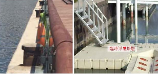
2 可考慮修改繫船柱旁的玻璃欄杆
